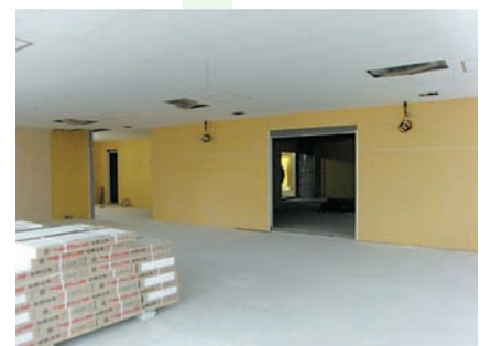
写真3 内装工事進捗(3/19時点)
